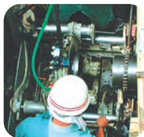
管内排土状況
