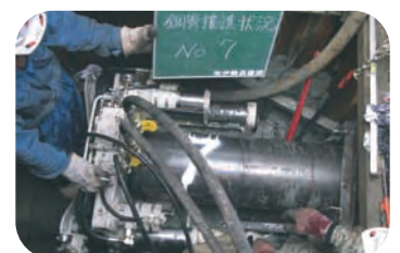
鋼管推進状況
