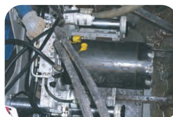
掘削ヘッド発進状況
