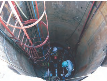
坑内発進状況
