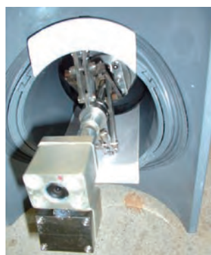
施工後の撮影確認
