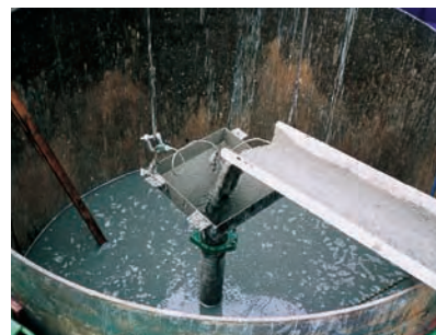
底スラブコンクリート打設
