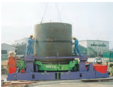
先端ケーシング建込
