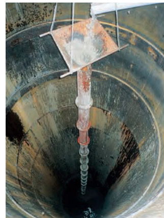
底スラブコンクリート打設
