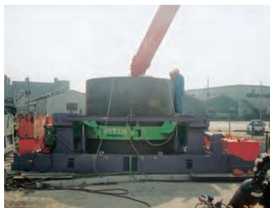
揺動圧入状況
