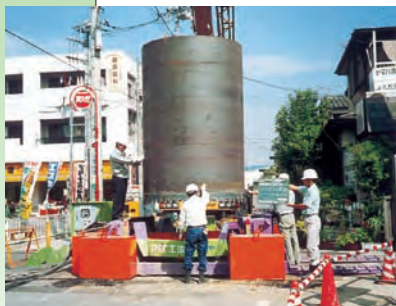
先端ケーシング建込
