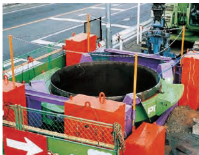
揺動圧入状況
