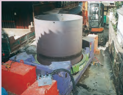
先端ケーシング建込
