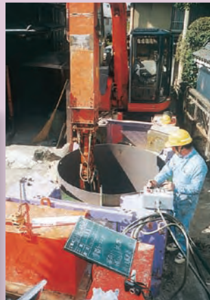
揺動圧入状況
