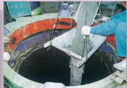
底スラブコンクリート打設
